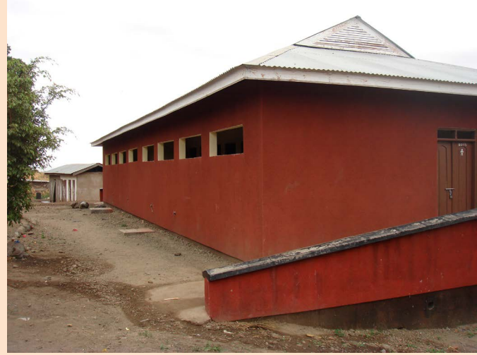
Das neue Toiletten-/Duschen-Gebäude für die 250 Schüler und 15 Lehrer
