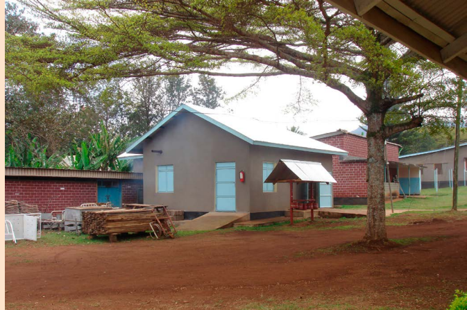
Das neue „Powerhäuschen“ schützt die Patienten vor Lärm und Abgasen.
